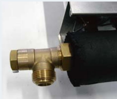
Fühleranschluss: Das T-Stück beherbergt den Kollektorfühler.
